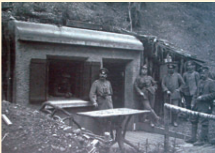
Hinter der Frontlinie legte man beim Bau der Betonunterstände oft grossen Wert auf Ästhetik und eine saubere Ausführung.
